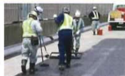
▲床版防水工の施工状況
