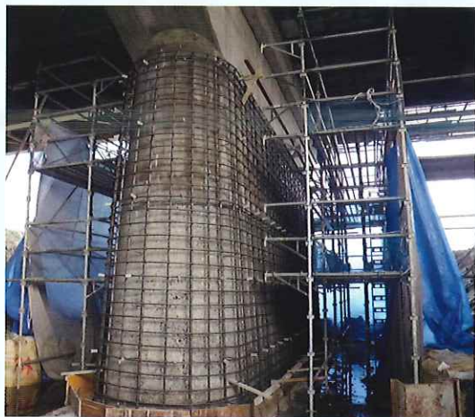
〔橋脚補強工事〕
