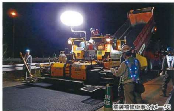
舗装補修工事(イメージ)
