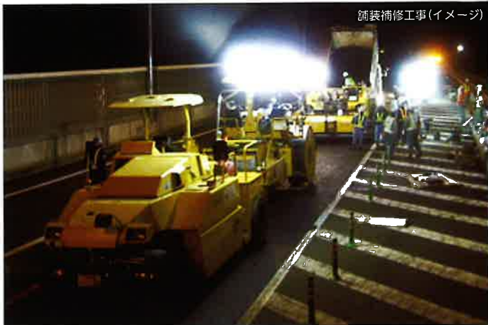
舗装補修工事(イメージ)
