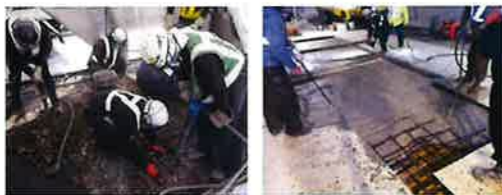
床版の部分打ち替状況(阪神高速14号松原線)
