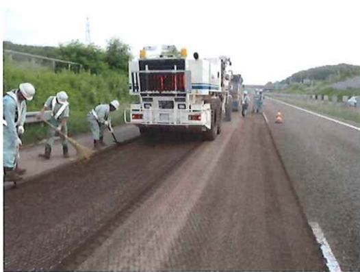
＜道路を削る作業＞
