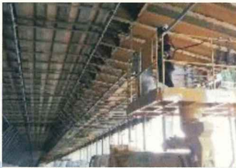
洞門内の梁部材補修状況
