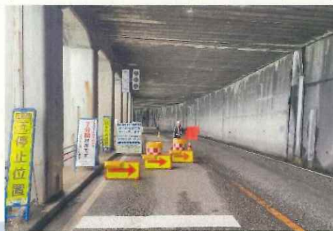
洞門内規制状況
