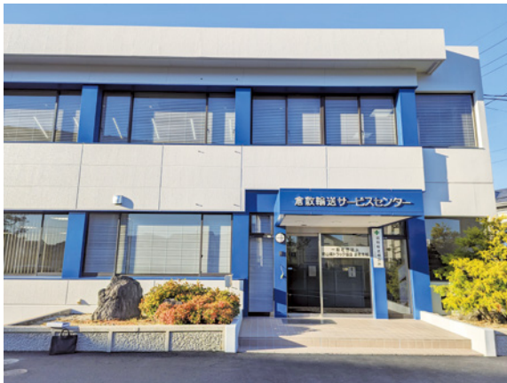
倉敷輸送サービスセンター 外観
