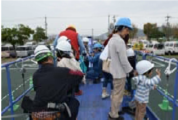
「これから高所作業車が上がっていくぞ」
