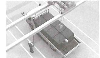
状況…トラックの荷台から、クレーンを用いて大型機材を降ろしていた。
