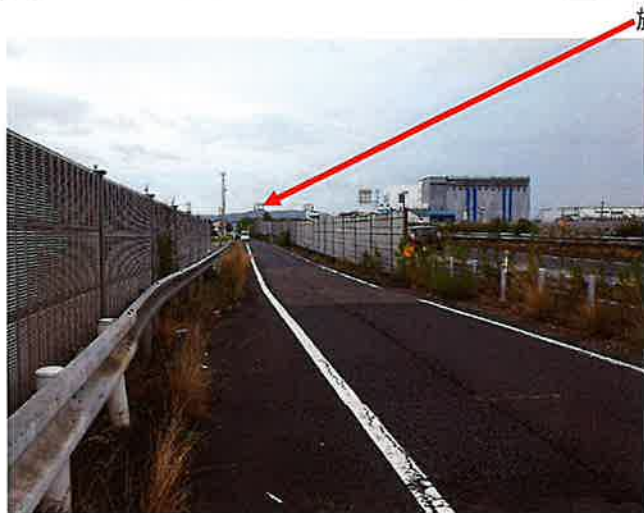
側道路肩規制
